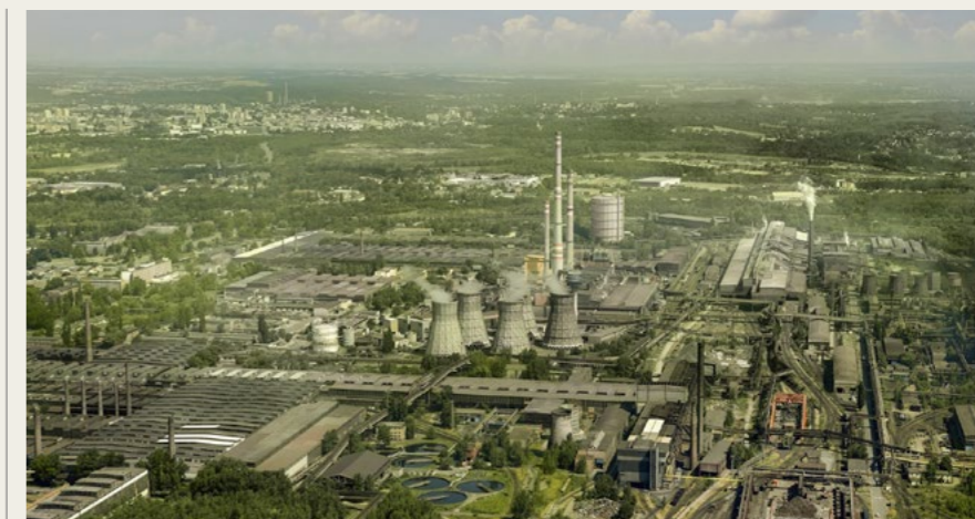
V roce 2015 ArcelorMittal Ostrava postaví 13 nadstandardních ekologických technologií v celkové hodnotě 3 miliardy korun
